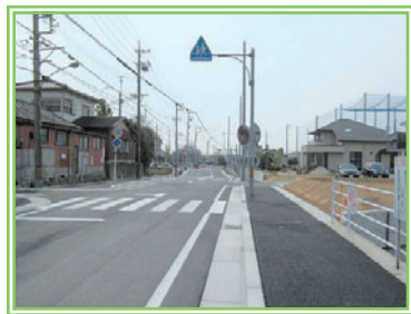
市杵島神社周辺の道路整備と、宅地の造成工事を行いました。
