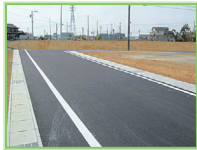
道路整備工事を行いました。
