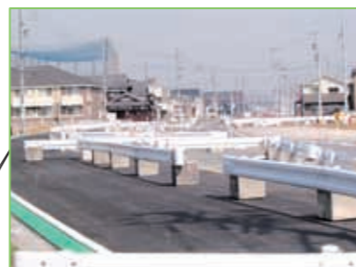
仮設道路の整備を行いました。
