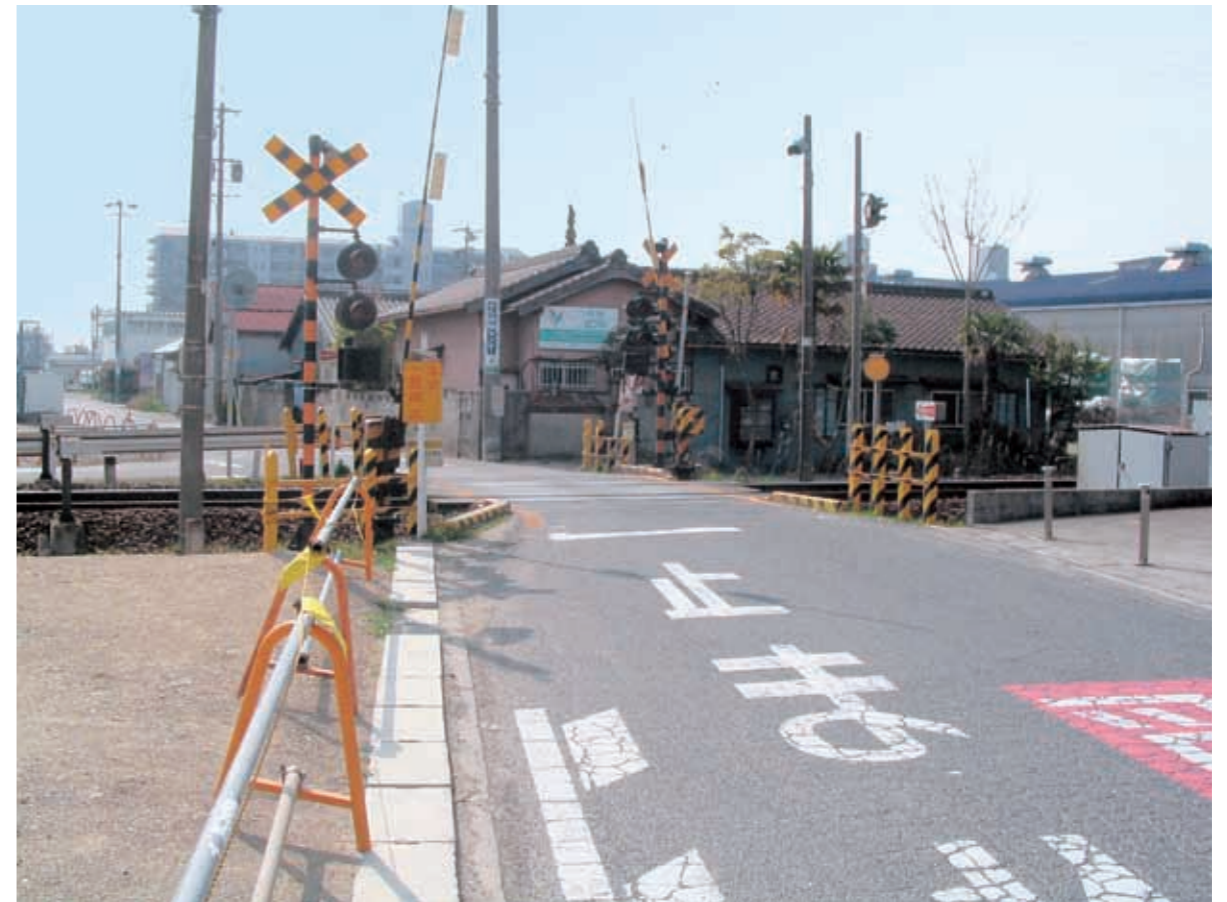
平成25年度に仮踏切の工事着工を予定している周辺
