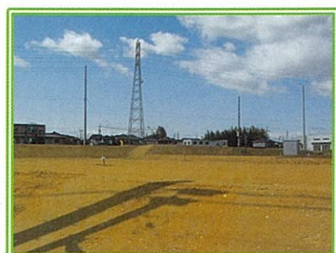
道路整備を含む、宅地造成工事をしました。
