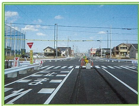
交差点を含む、環状線の工事をしました。平成24年度中には信号機が設置される予定です。
