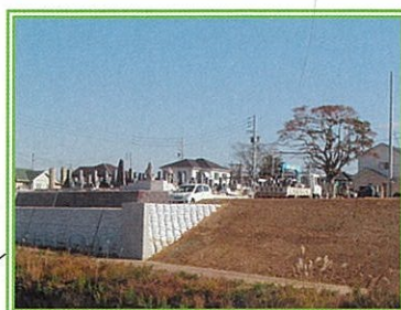
平地墓地周辺を整備しました。併せて、周辺道路の整備と宅地の造成工事をしました。
