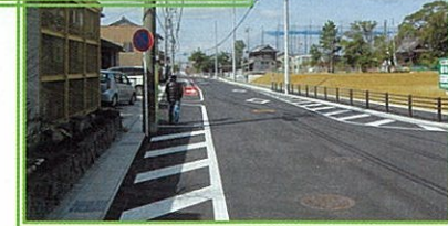
乙川東小学校東側道路や市杵嶋神社周辺を整備しました。
