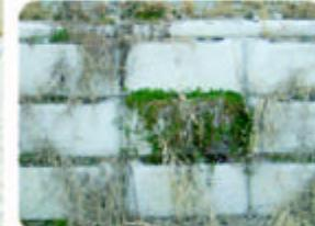
新しい平地川の護岸には、緑化ブロックが設置されています。緑化ブロックを組み合わせて施工することにより、自然に近い生態系保全護岸を造ることができます。魚や昆虫の棲息が確保できます。
