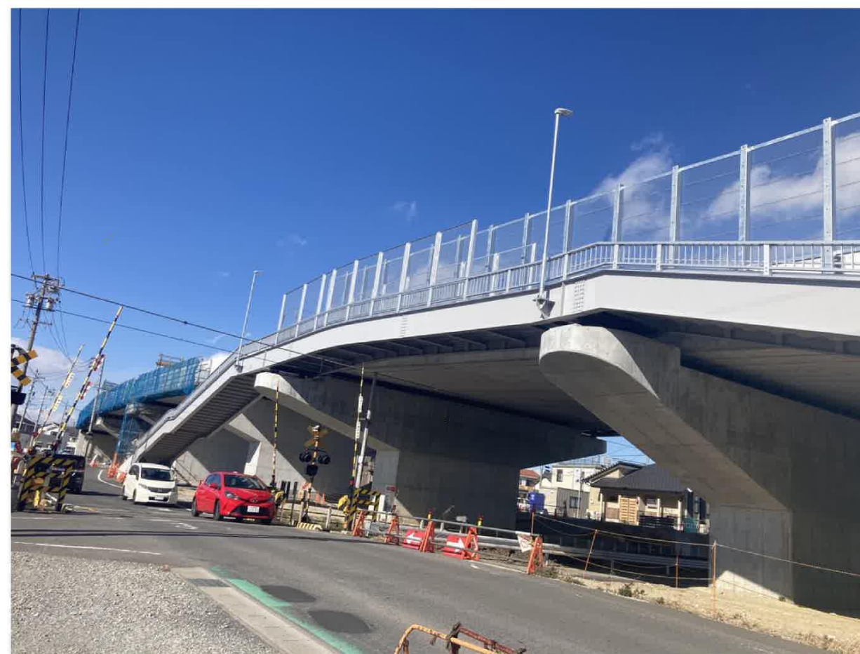
跨線橋（JR武豊線踏切付近）の様子
