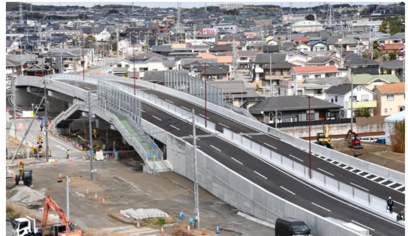
跨線橋（環状線）
