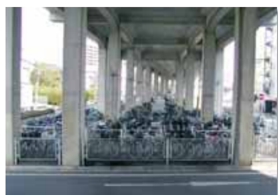
高架下駐輪場
