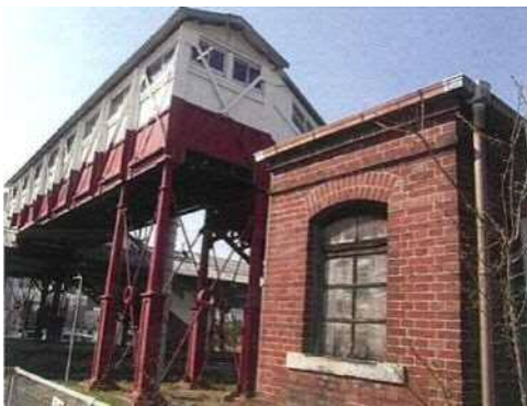
跨線橋・油庫
