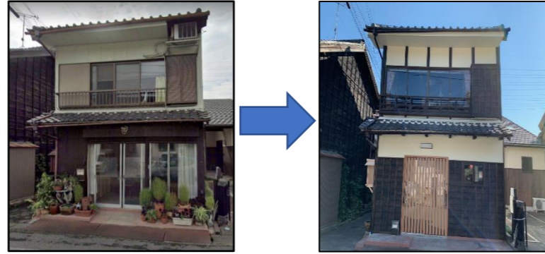
○外壁板張り・塗装、玄関・窓取り替え
