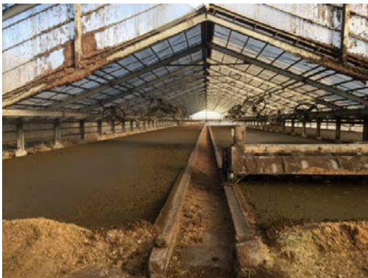
写真 2-6 M 牧場 1 次処理施設内観①
