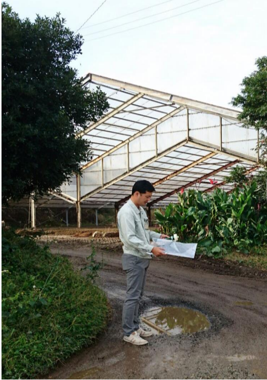
写真 4-1.敷地境界線①
