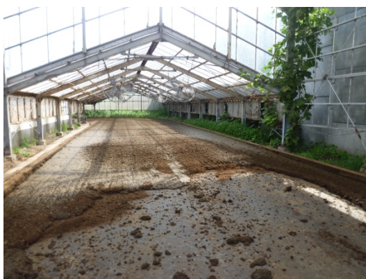
写真2-1 一次処理場 搬入口
