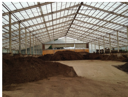
写真2-4 二次処理場内
