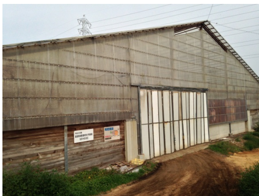
写真2-3 二次処理場外観
