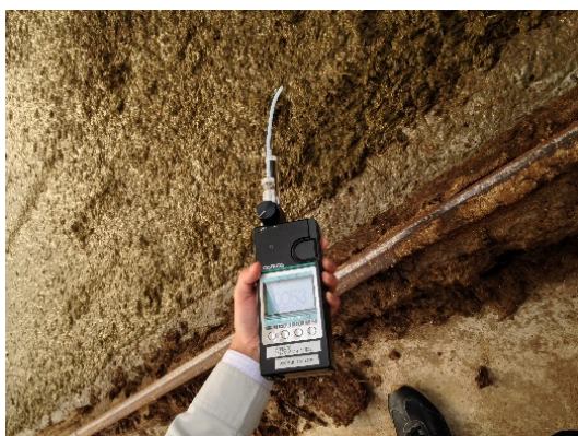
写真 4-1 一次処理場 センサ [A] 測定
