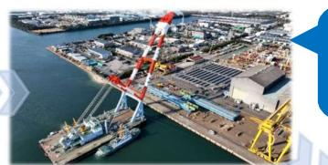
②工場で橋桁を製作し、クレーン船で台船に載せます。
