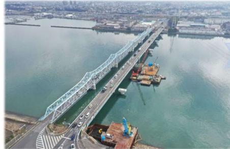
①橋桁を支える橋台、橋脚を工事しています。
