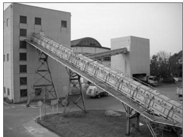
写真 3-2 粗大ごみ処理施設
