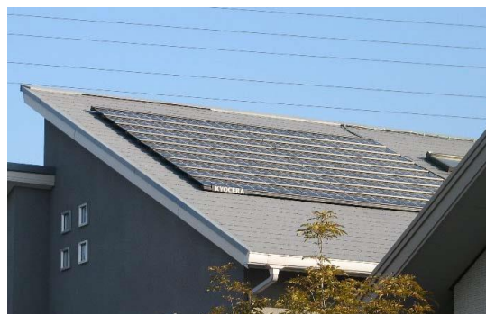
太陽光発電システム
