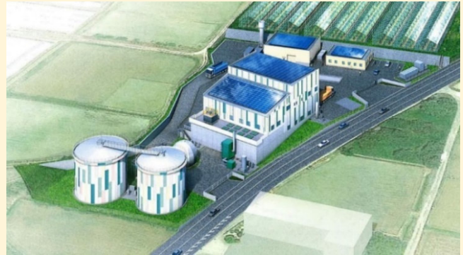
バイオガス発電施設（令和 3 年 10 月から稼働予定）
