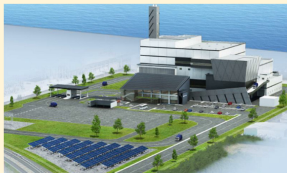
知多南部広域環境センター（令和4年4月供用開始予定）
