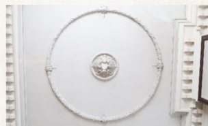
漆喰で飾り付けされた天井
