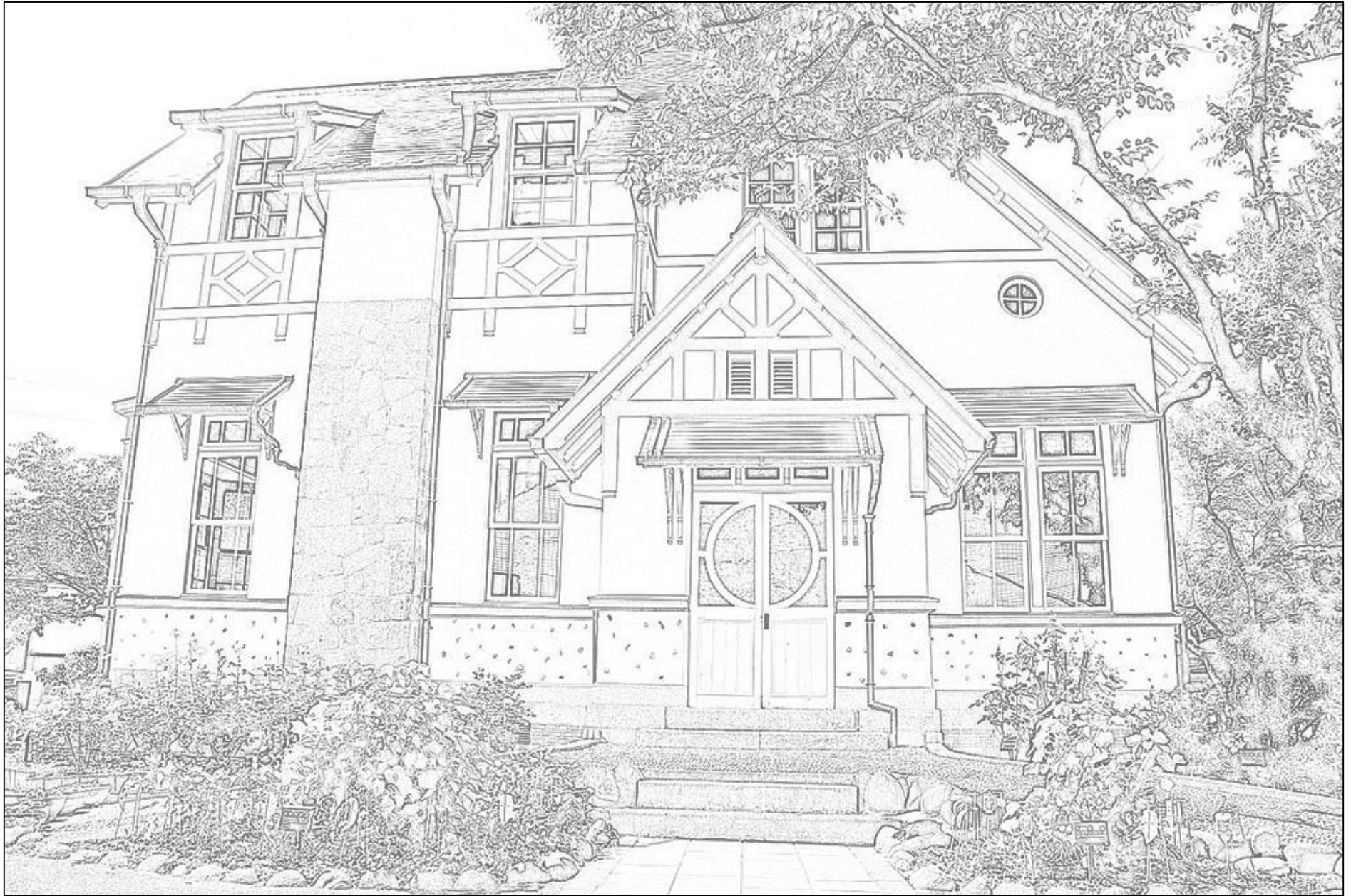
重要文化財 旧中埜家住宅 1911年建築 愛知県半田市天王町
