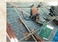
天然スレートの葺替
