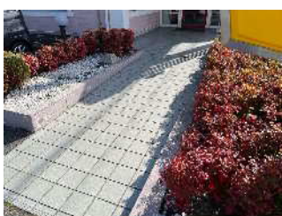
スロープの設置
