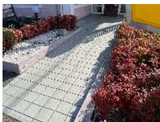
スロープの設置
