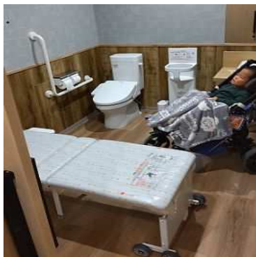
車いすでも楽々なトイレ空間
