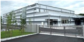
半田市学校給食センター
