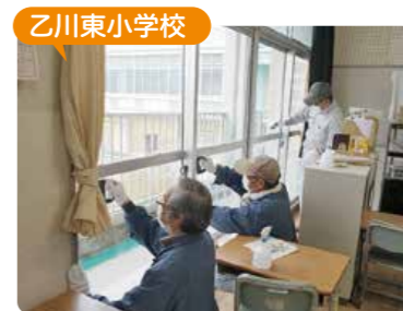
乙川東小学校 劣化したガラス飛散防止フィルムを新しいものに貼り直しています。
