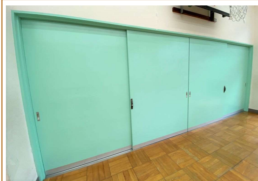
遊戯室倉庫扉 塗り替え
