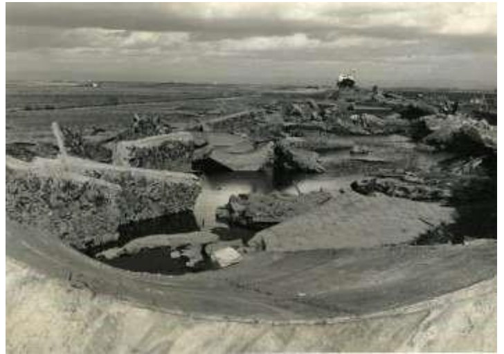
海岸堤防破壊のため、長期間浸水した新栄町方面 堤防が決壊した康衛町方面 (台風時には、水深3メートルを超え、二階まで浸水)
