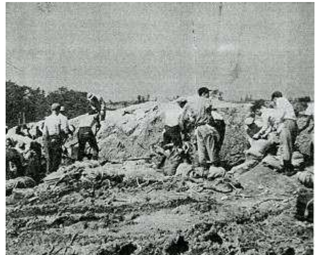
青年団の土のう作り
