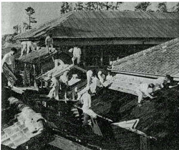
P T Aによる被害校舎修理
