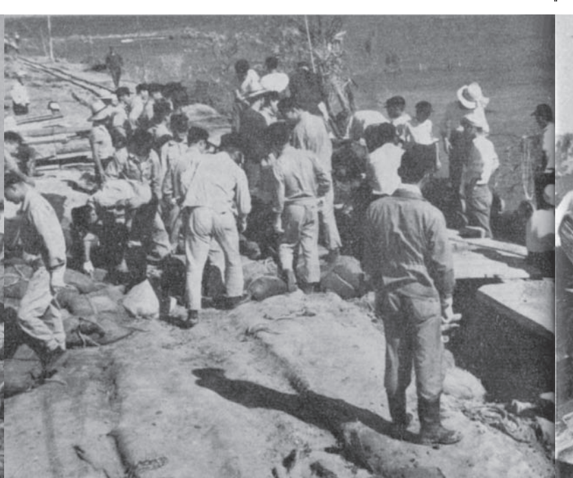
高校生の土のう運び
