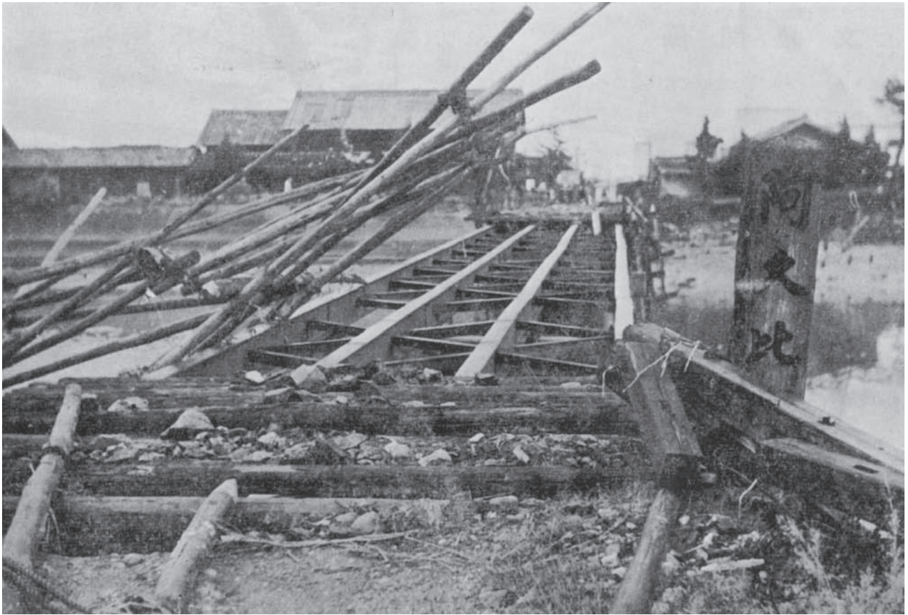
阿久比川下流江川橋は上部を流失
