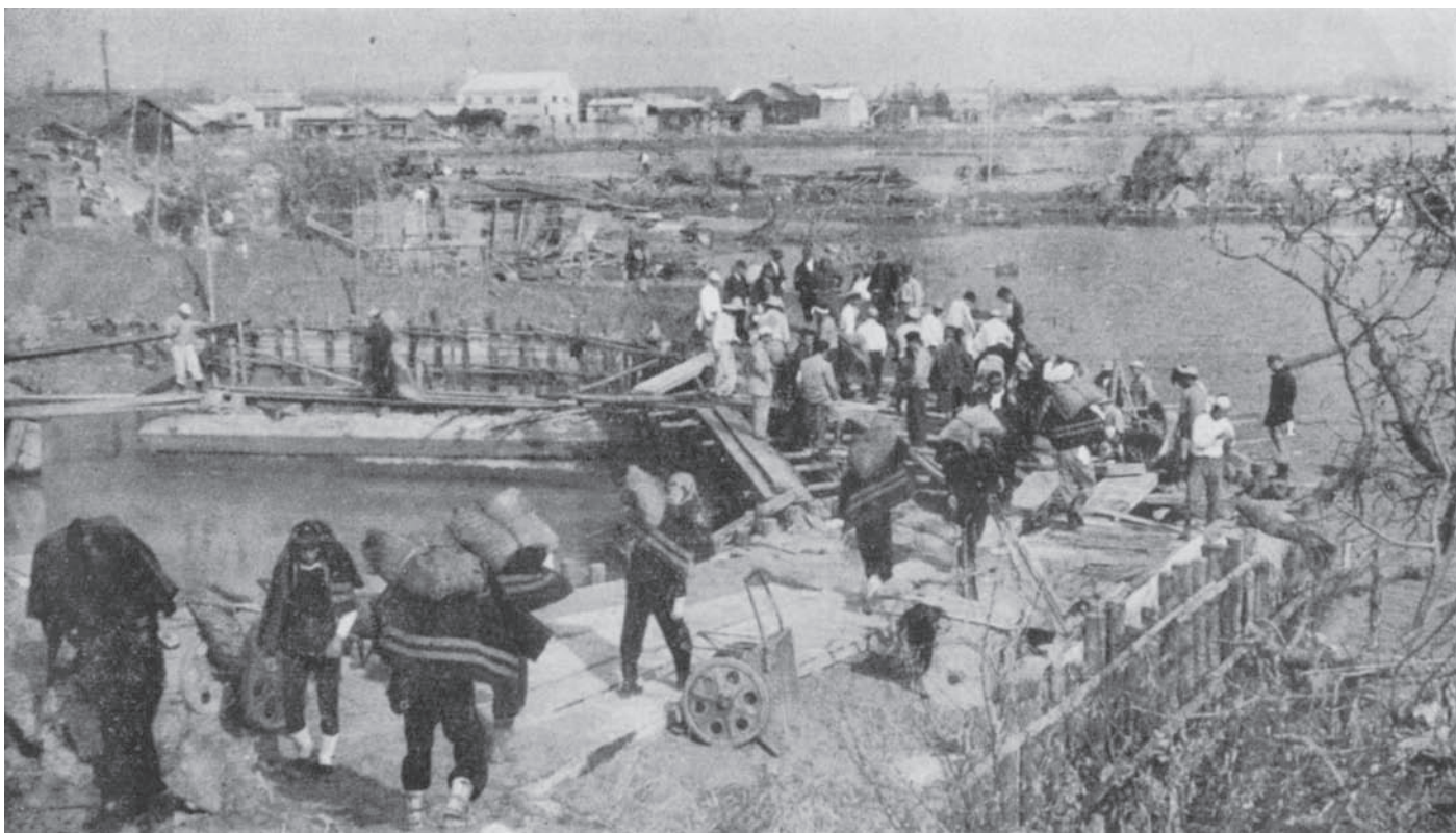
決壊堤防の仮締切作業
