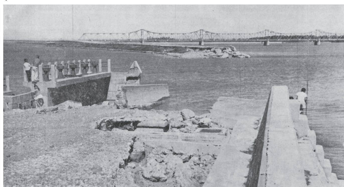
衣浦干拓堤防（二級国道）100メートルが決壊し、衣浦大橋も通行止め
