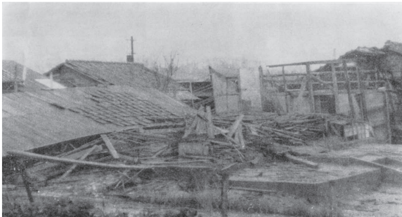
全壊した大池町公民館
