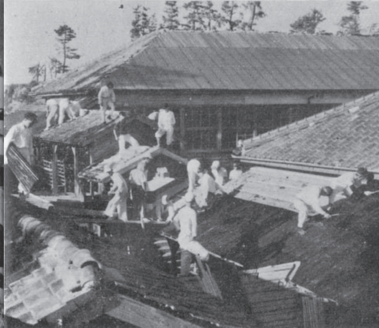
PTAの被害校舎修理
