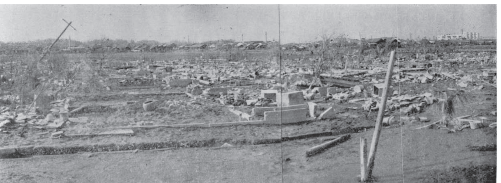
一夜に住宅多数が全壊流失し多くの犠牲者が出たところ
