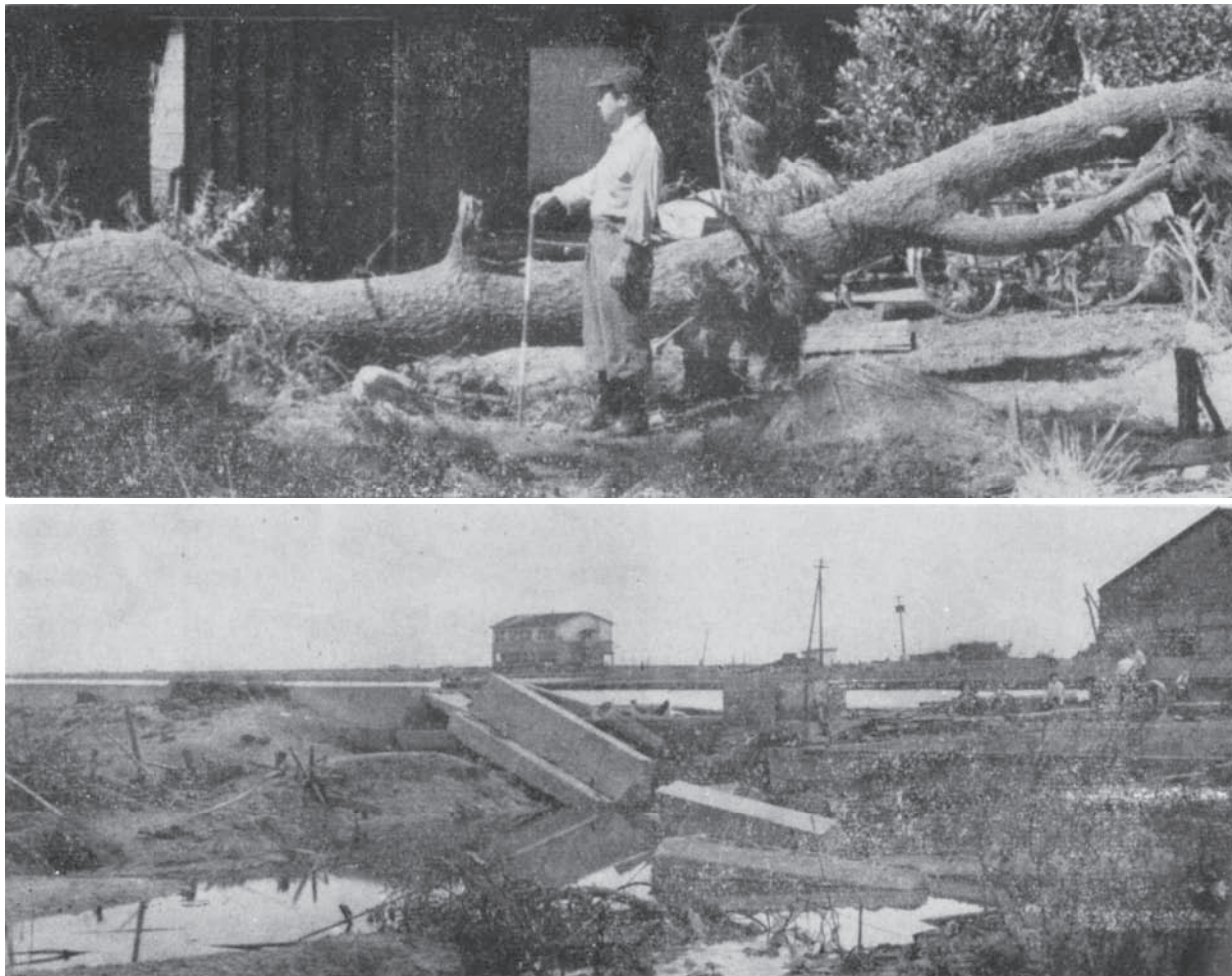
強風で庭の巨木も倒れ——高潮でコンクリート堤防もこの始末
