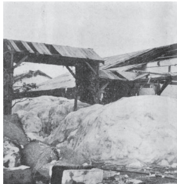
原材料の被害も大きかった紡績工場
